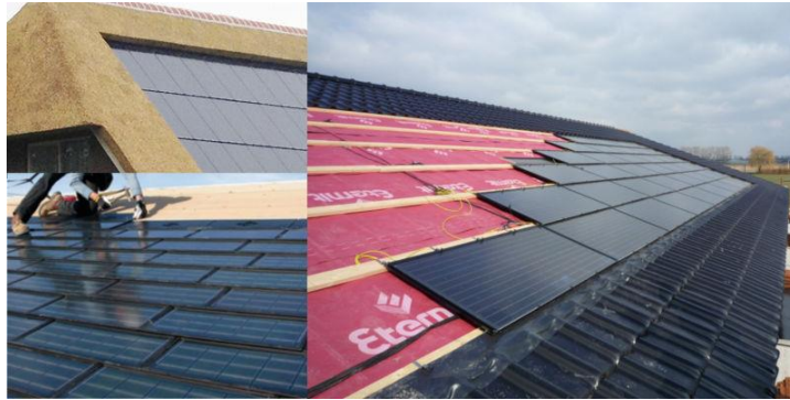
Afbeelding 4.4: Voorbeeld van grote zonnestelsels geïntegreerd in het dakontwerp.
